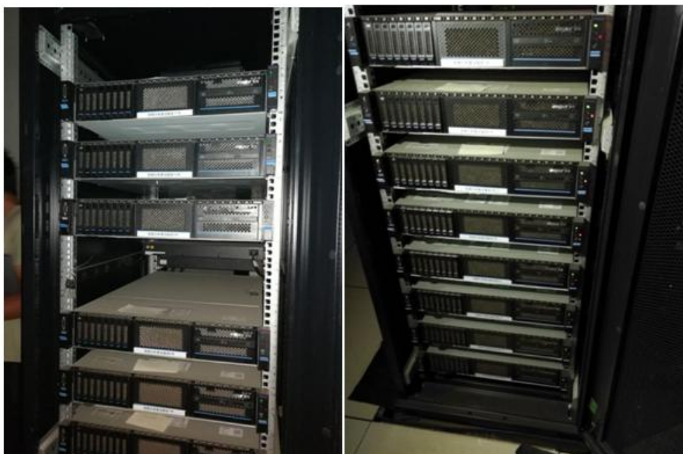
图 3.4-1 安全畅通与应急处置系统的视频检测系统
